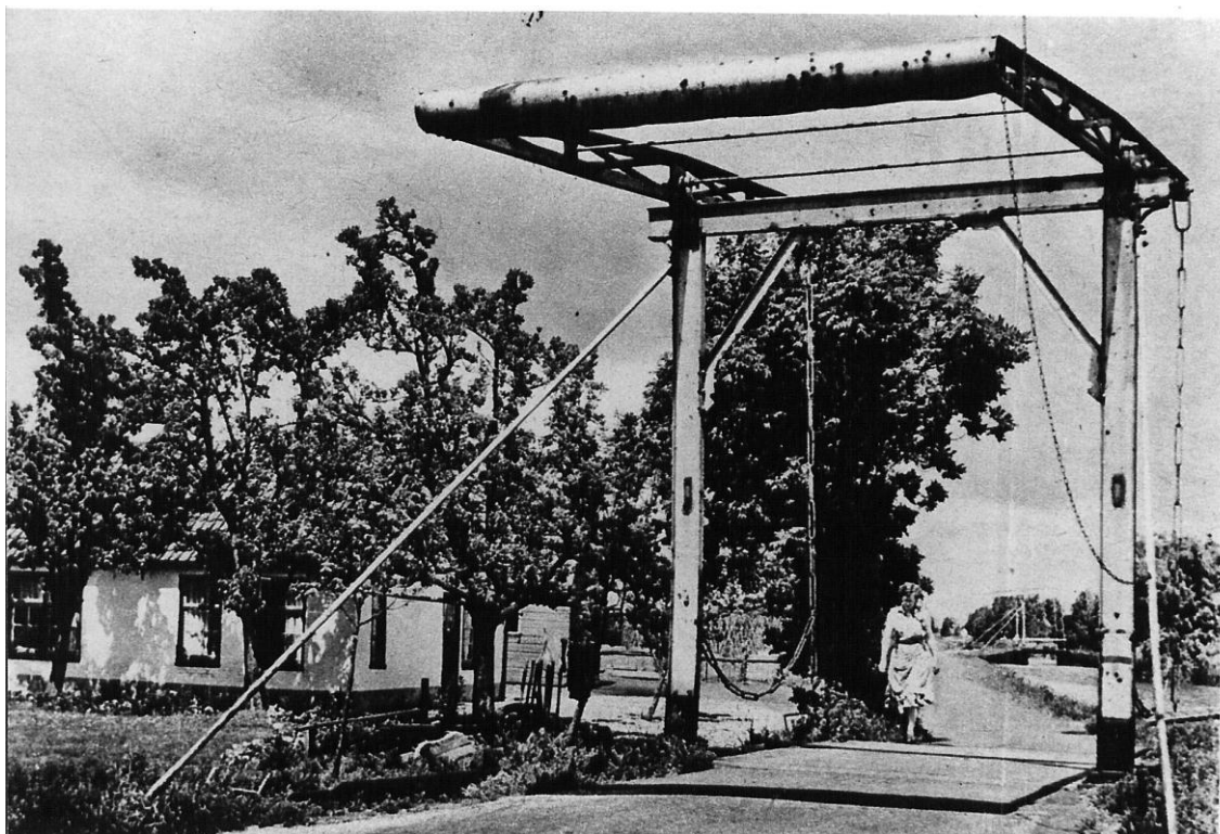
Afbeelding 57: Vieressenbrug, inmiddels vervangen door een dam.
