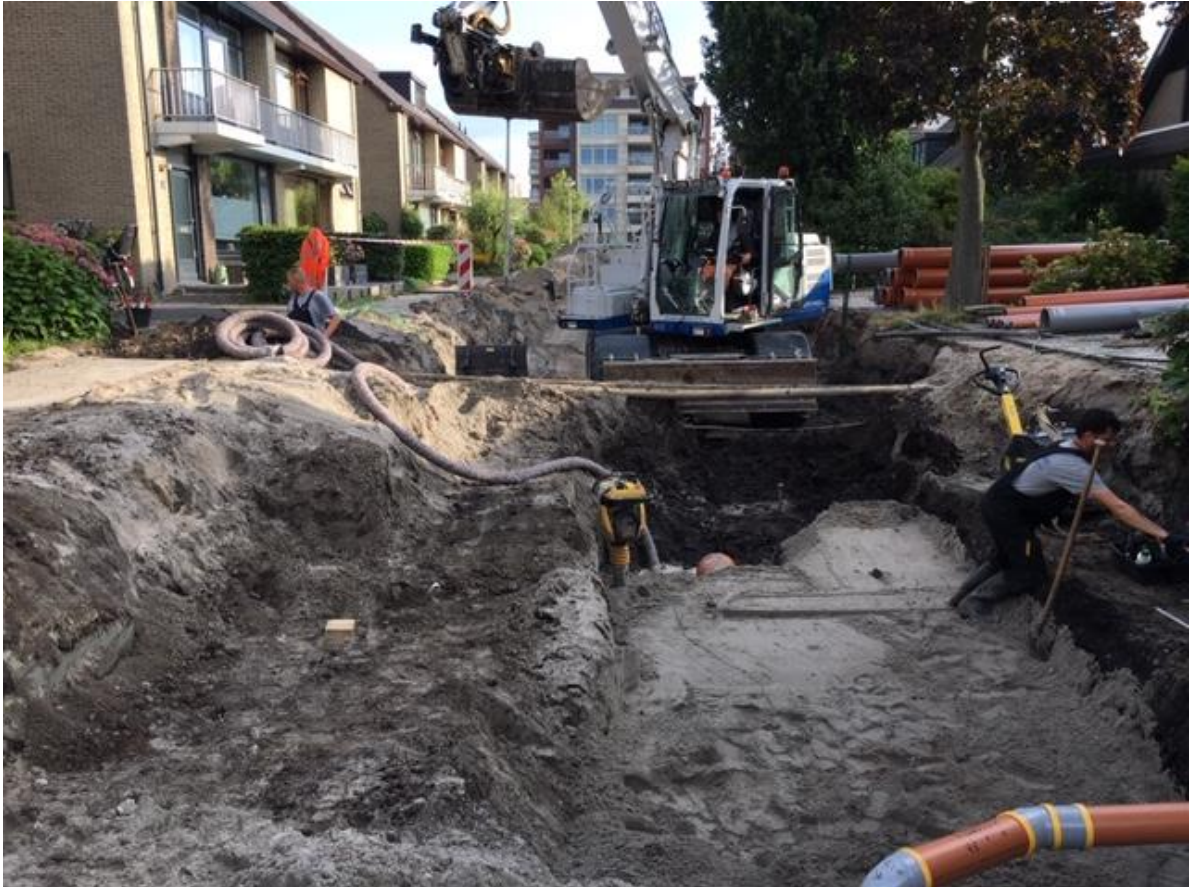
Voorbeeld van machines die in de rijbaan een brede sleuf graven voor de riolering.
