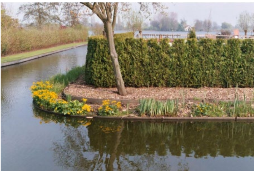
Figuur 2 - oeverbescherming met beplanting
