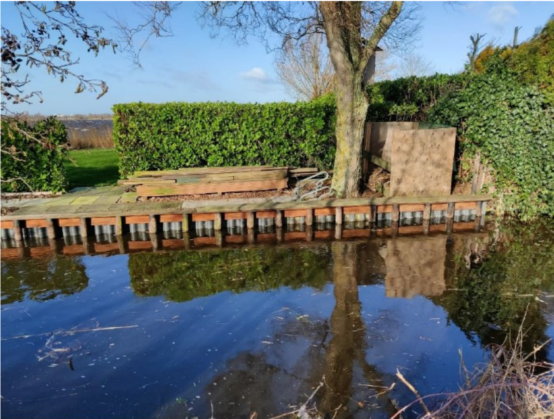
Figuur 21 Duidelijker beeld van de beschoeide oever. De oever zelf is ook geheel verhard, er staat een fietsenrek en er liggen meerdere bouwmaterialen op het verharde gedeelte.
