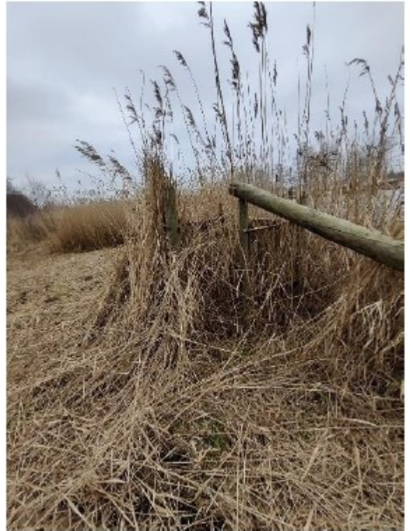
Figuur 1 Schiethut vanuit het noorden gezien
