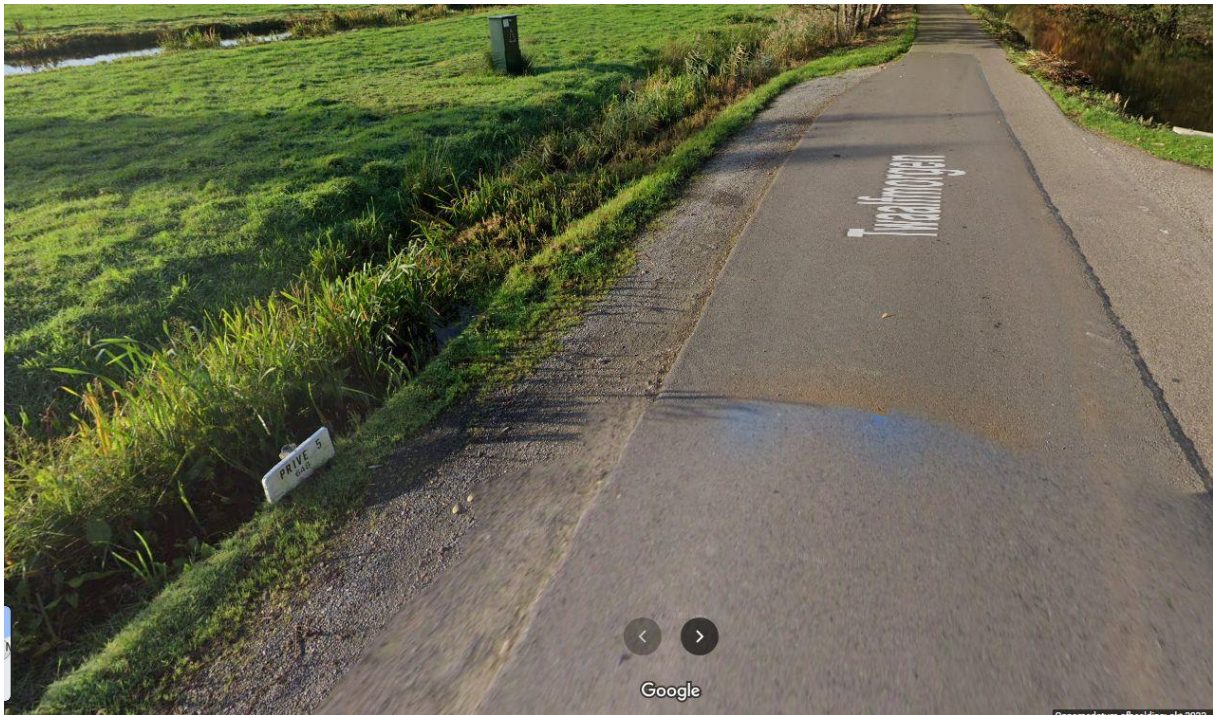
Foto – (Privé) Parkeerplaats met puinverharding in de berm
