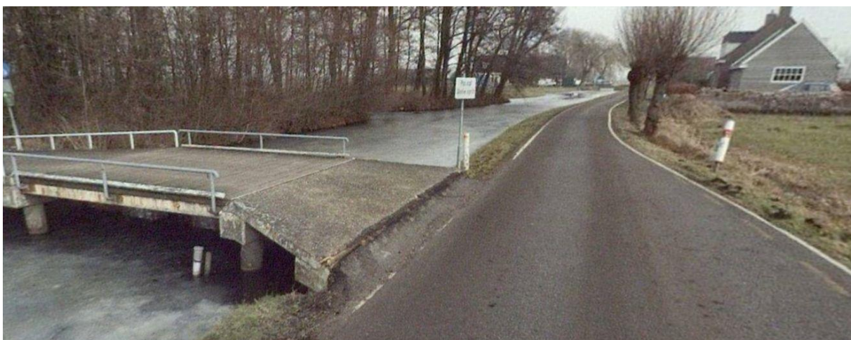
Foto – Aansluiting brug op zakkende weg
