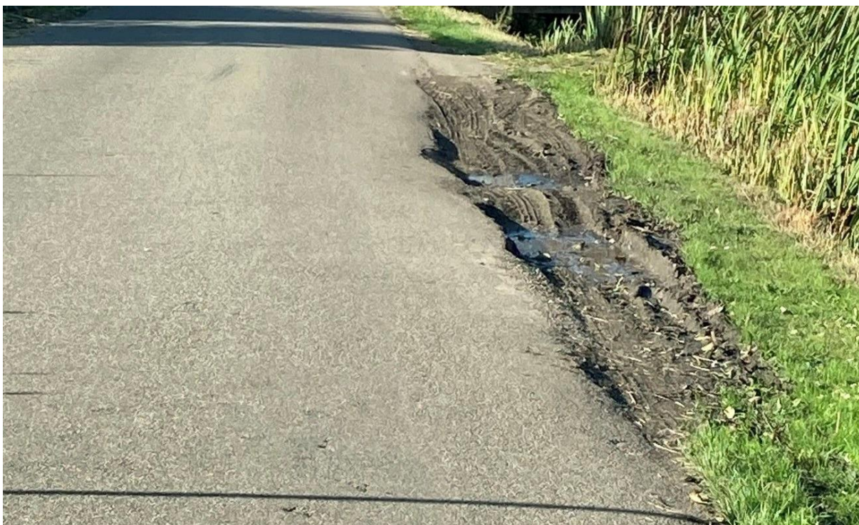
Foto – Spoorvorming
