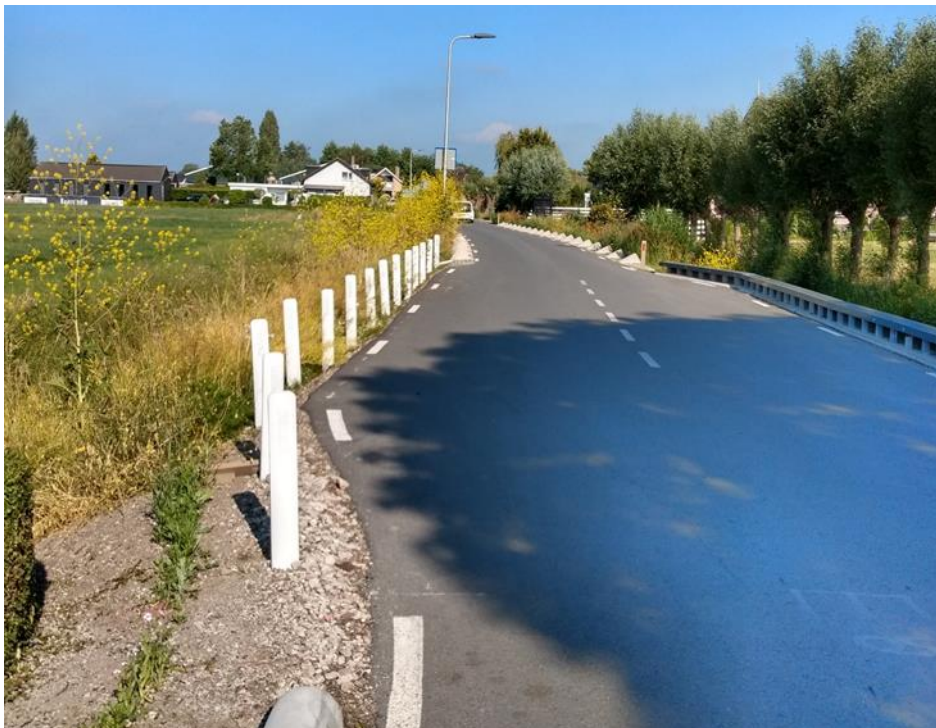
Foto – Witte kunststof bermpalen langs steil talud
