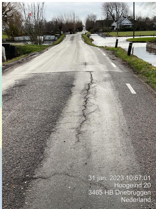
Scheurvorming
