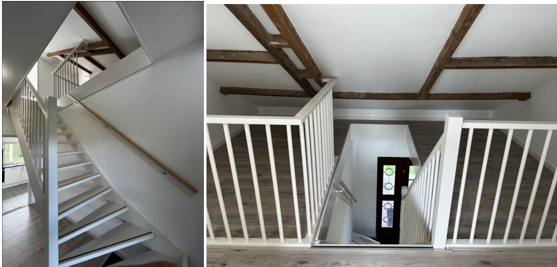
Foto's binnenkant eerste verdieping
