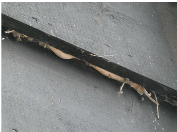
Figuur 12: Houten afwerking op een van de gebouwen in het plangebied.
