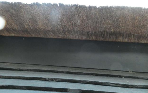
Figuur 10: Afwerking met hout bij een gebouw met een rieten dak in het plan gebied.
