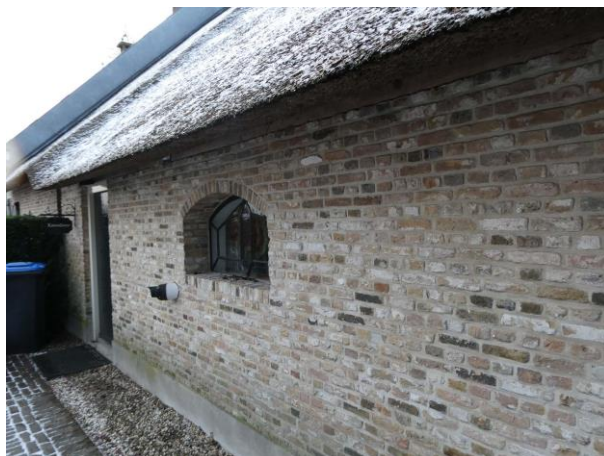
Figuur 13: Stenen muur van een van de gebouwen in het plangebied
