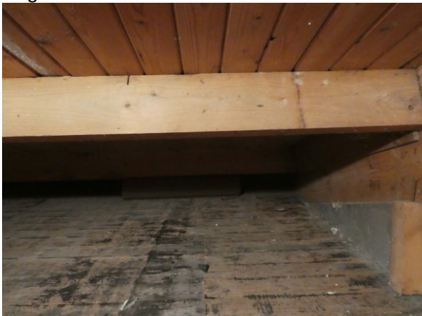
Figuur 10 Afwerking dakbeschot vanaf binnen in de woning
