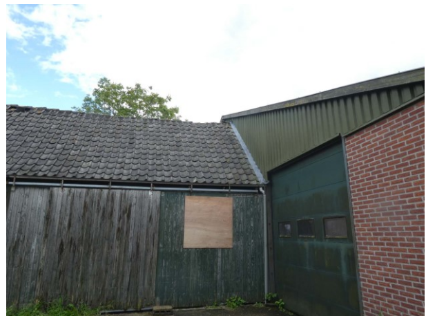
Figuur 5 Schuur aansluitend aan de loods
