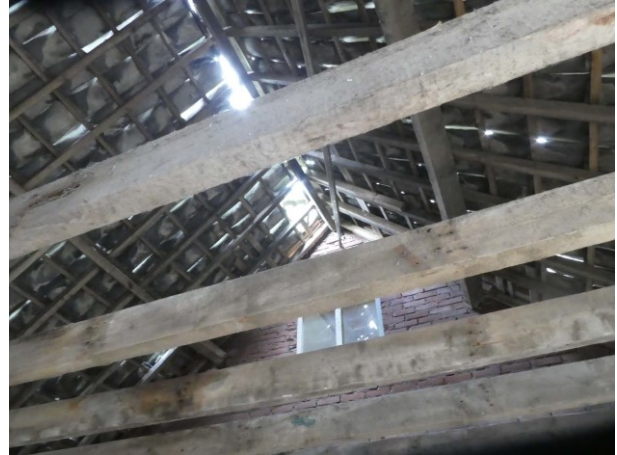
Figuur 9 Open dak van de schuur
