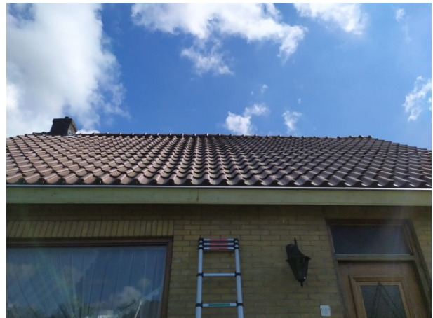
Figuur 11 Overzicht pannendak van de woning
