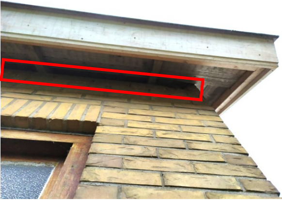
Figuur 12 Buitenzijde van de sleuf
