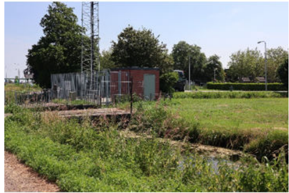
Zendmast in noordelijk deel plangebied.
