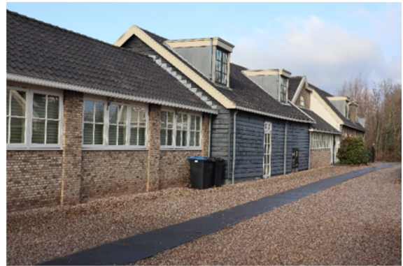
De te slopen bebouwing achter de woning.
