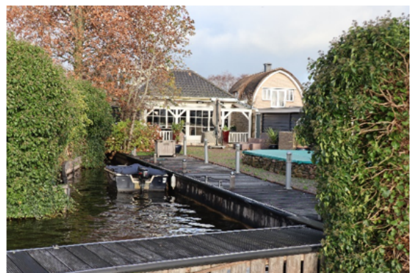
Bestaand water voor aantakking binnenhaven.
