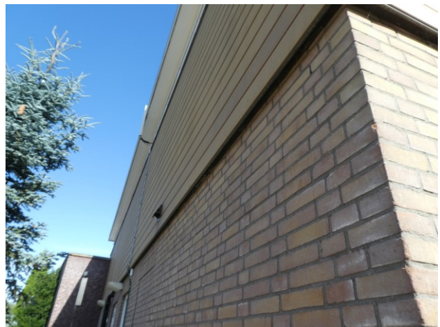
Figuur 16 Houten gevelbekleding
