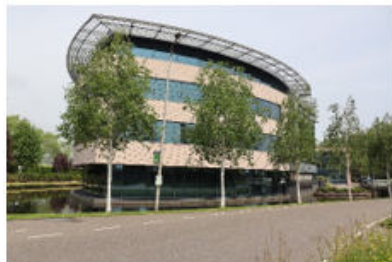
Kantoor Het Bakken.
