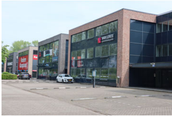
Bedrijfsbebouwing aan zijde van rijksweg A12.
