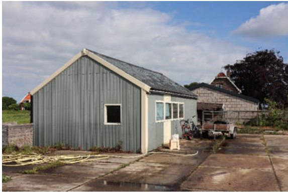
Te slopen bedrijfsschuur binnen bouwvlak.
