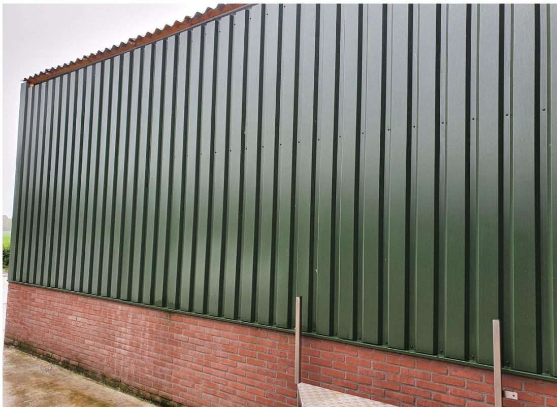
Bestaande gevel van de kaasmakerij
