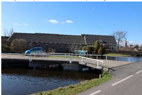
Bedrijfscomplex aan Nieuwdorperweg 59.
