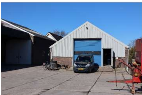
Te slopen bebouwing op achtererf.
