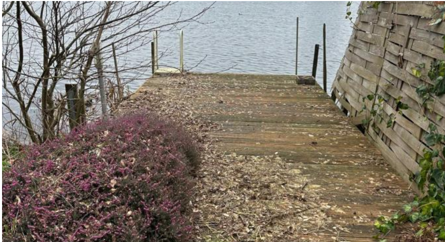
3. Bestaande vlonder aan oostzijde plangebied
