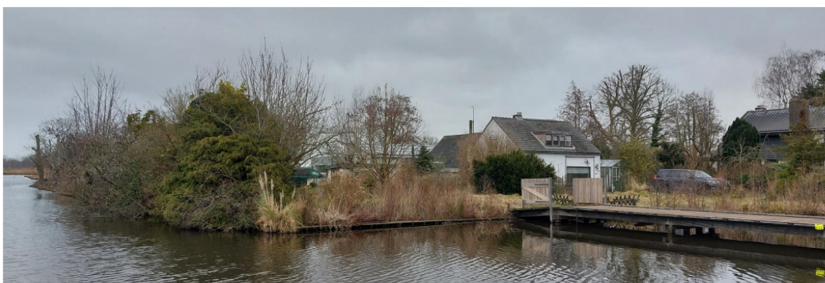
5. Bestaande brug naar entree achterliggende woning
