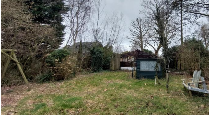
1. Diversiteit aan vervallen bouwwerken/recreatiewoningen op kavel
