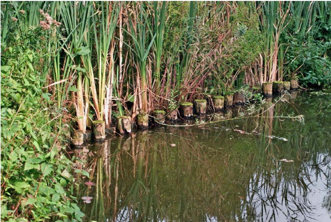
Afbeelding 40: Constructie type A: palenrij met gording en doek, achter de beschoeiing ingeplant met inheemse oeverplanten.
