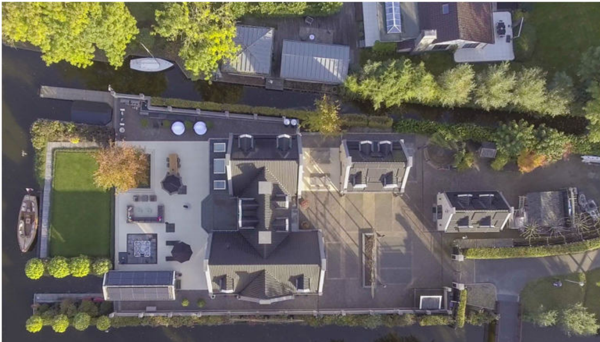
Luchtfoto perceel Platteweg 7 in Reeuwijk.
